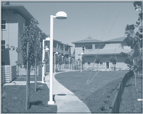
ENERGY ALIUMINCO ESHA
